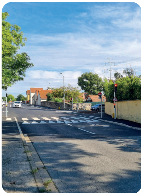
Entretien de la voirie, Lardy
